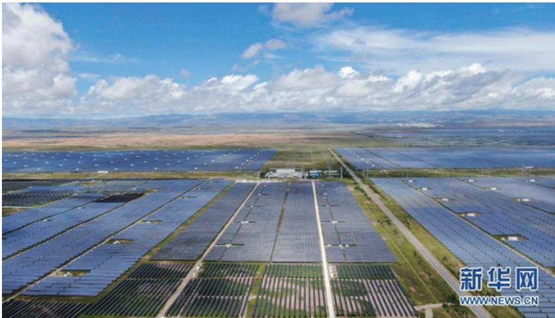
图2 青海省海南藏族自治州共和县塔拉滩绿色产业发展园区光伏电站 图片来源：新华网。
