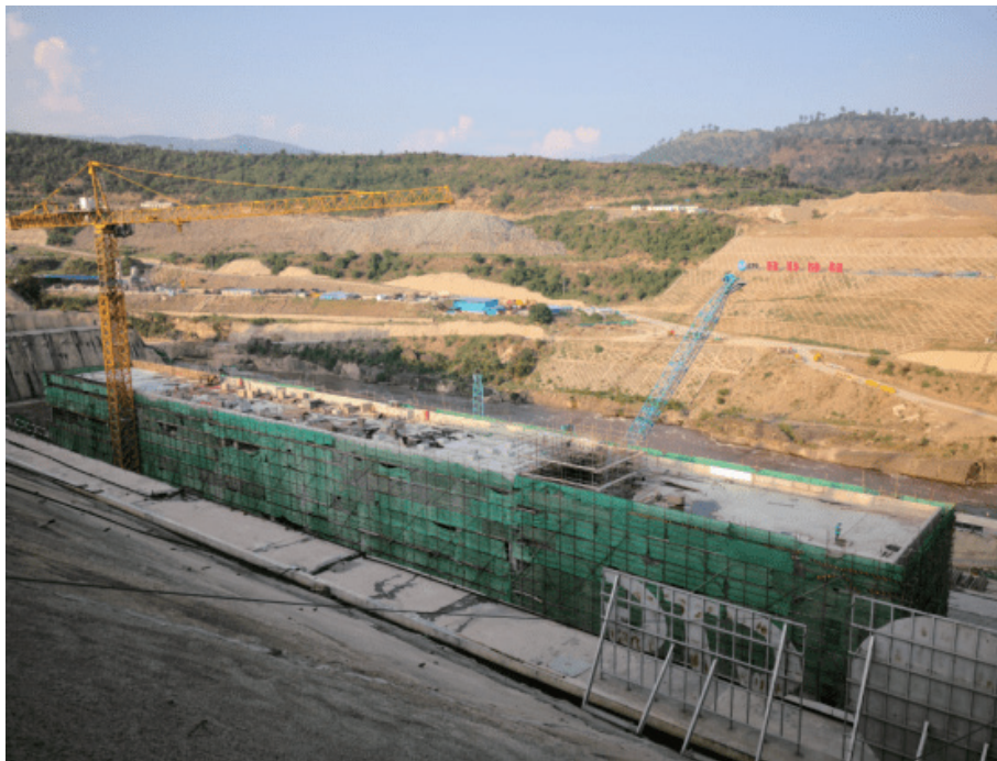
图3 2020年6月巴基斯坦卡洛特水电站项目开关站顺利封顶
